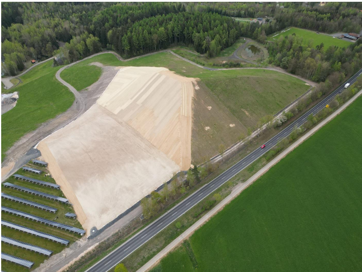
Abbildung 1: Dichtungsbau am BA B und BA C, Stand: April 2024
